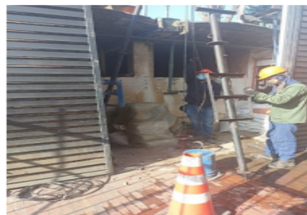
Foto No. 6. Anclaje al trípode para extracción de tubería
