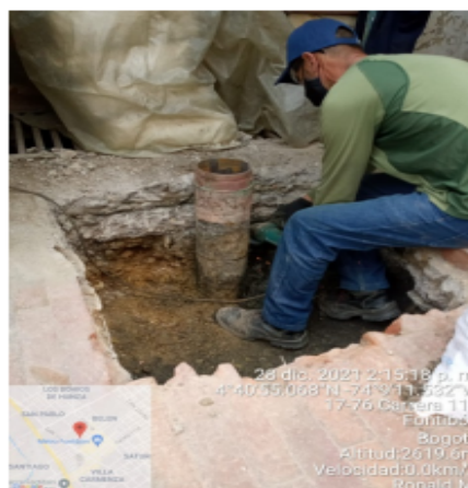
Foto No. 10. Corte de tubería de revestimiento
