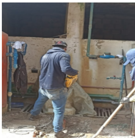
Foto No. 9. Excavación de 1mX1m y 50cm de profundidad
