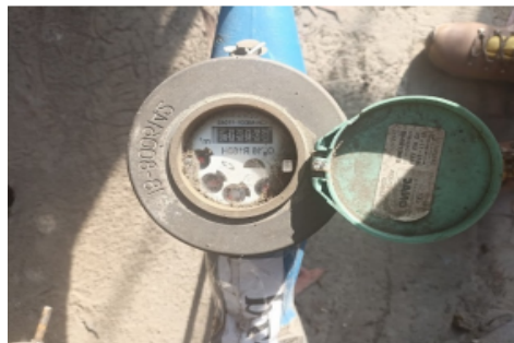
Foto No. 4. Medidor marca WATERTECH serial 18-8006142 y una lectura acumulada de 1915 m 3
