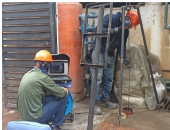
Foto No. 8. Video y profundidad del pozo
