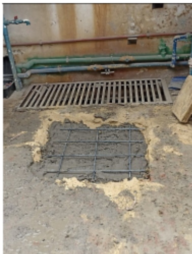
Foto No. 14. Refuerzo de placa con varilla de hierro de 3/8
