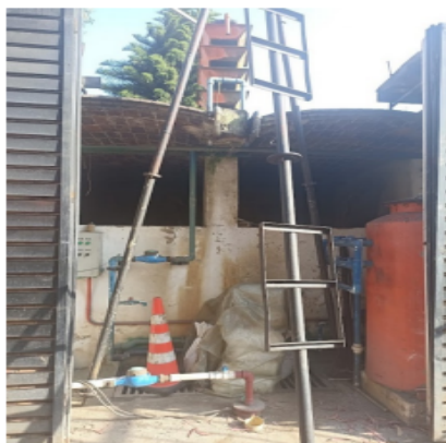
Foto No. 3. Vista general del pozo
