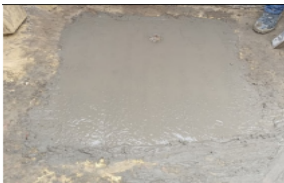
Foto No. 16. Sellamiento definitivo del pozo pz-09-0019
