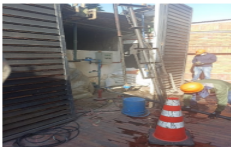
Foto No. 5. Corte de la tubería para retirar el medidor
