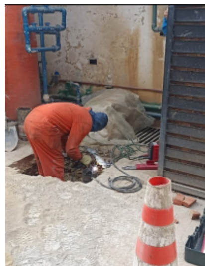
Foto No. 13. Actividad de soldadura del tapón
