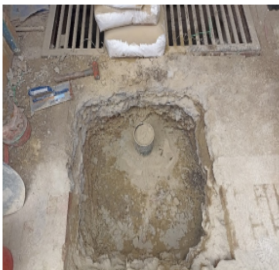
Foto No. 12. Relleno con mezcla 1 a 1 bentonita y cemento
