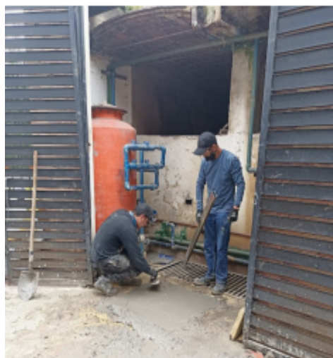
Foto No. 15. Fundición de placa
